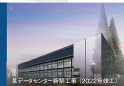
某データセンター新築工事 (2022年竣工)
