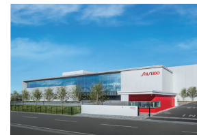
資生堂久留米工場生産設備 (2022年竣工)
